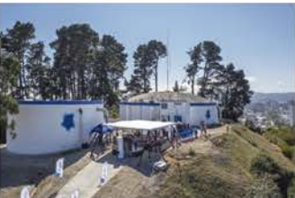
✧ Estanque de agua potable Chepe, Concepción.
