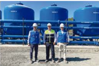
✧ Etapa final nueva planta de agua potable Buen Retiro, Coronel.
