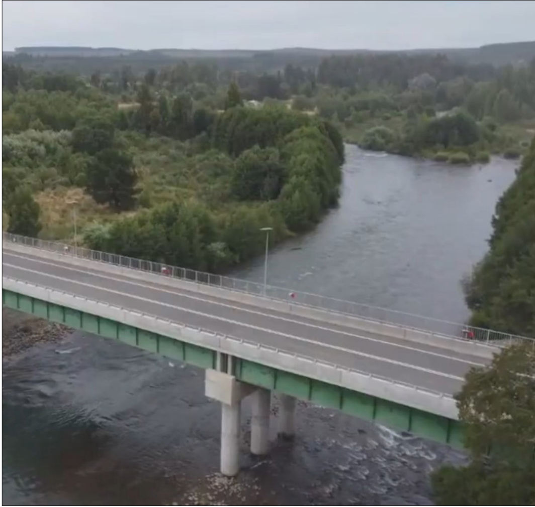
REMOCIÓN DE MATERIAL SEDIMENTADO, ENTRE OTRAS FAENAS
