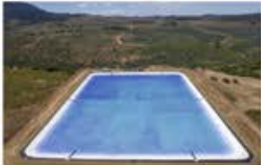
Nuevo Tranco Ninhue, 40 millones de litros
