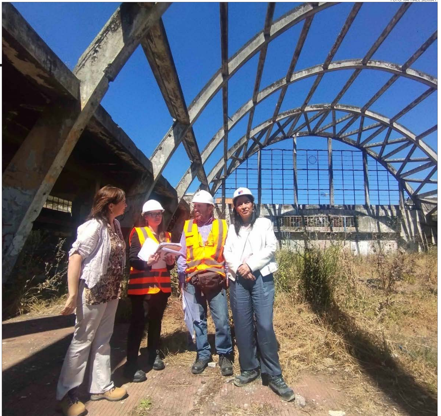
LA CÚPULA FUE construida de hormigón armado.
