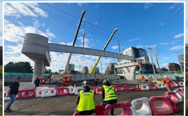
PRIMERA VIGA en el viaducto que unirá el Puente Bicentenario con Avenida Chacabuco. Se instaló este viernes en Concepción.
