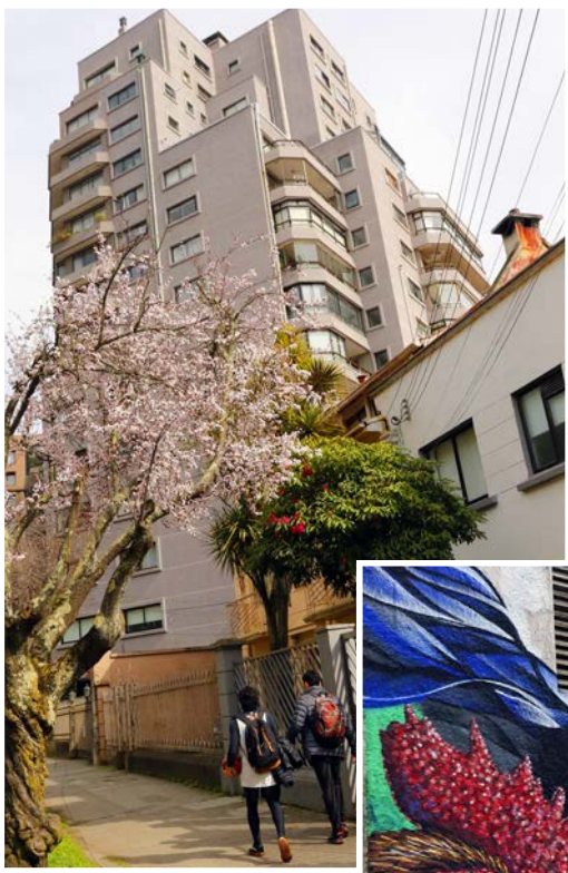
EDIFICIOS apuestan con sus formas a marcar la diferencia en el sector.
