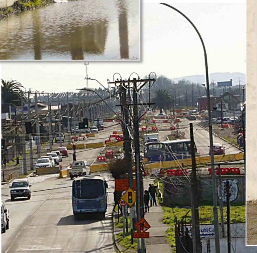
BARRERAS de contención y que muestran el trazado provisorio.
