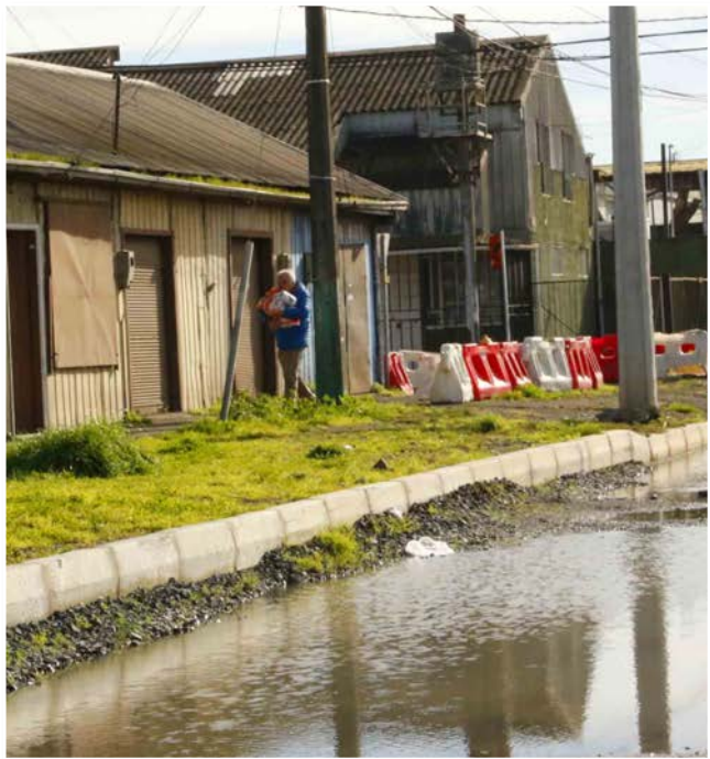
AGUA estancada a un costado de la vereda.
