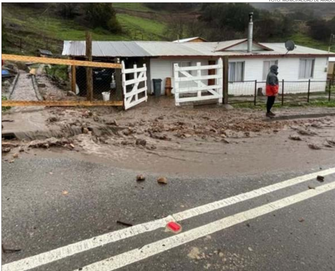
EN ARAUCO, en Punta Lavapié un deslizamiento ingresó a una vivienda.
