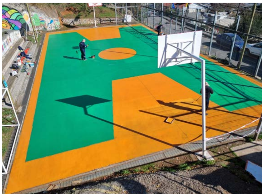
MULTICANCHA RECUPERADA, Cerro La Pólvara.
