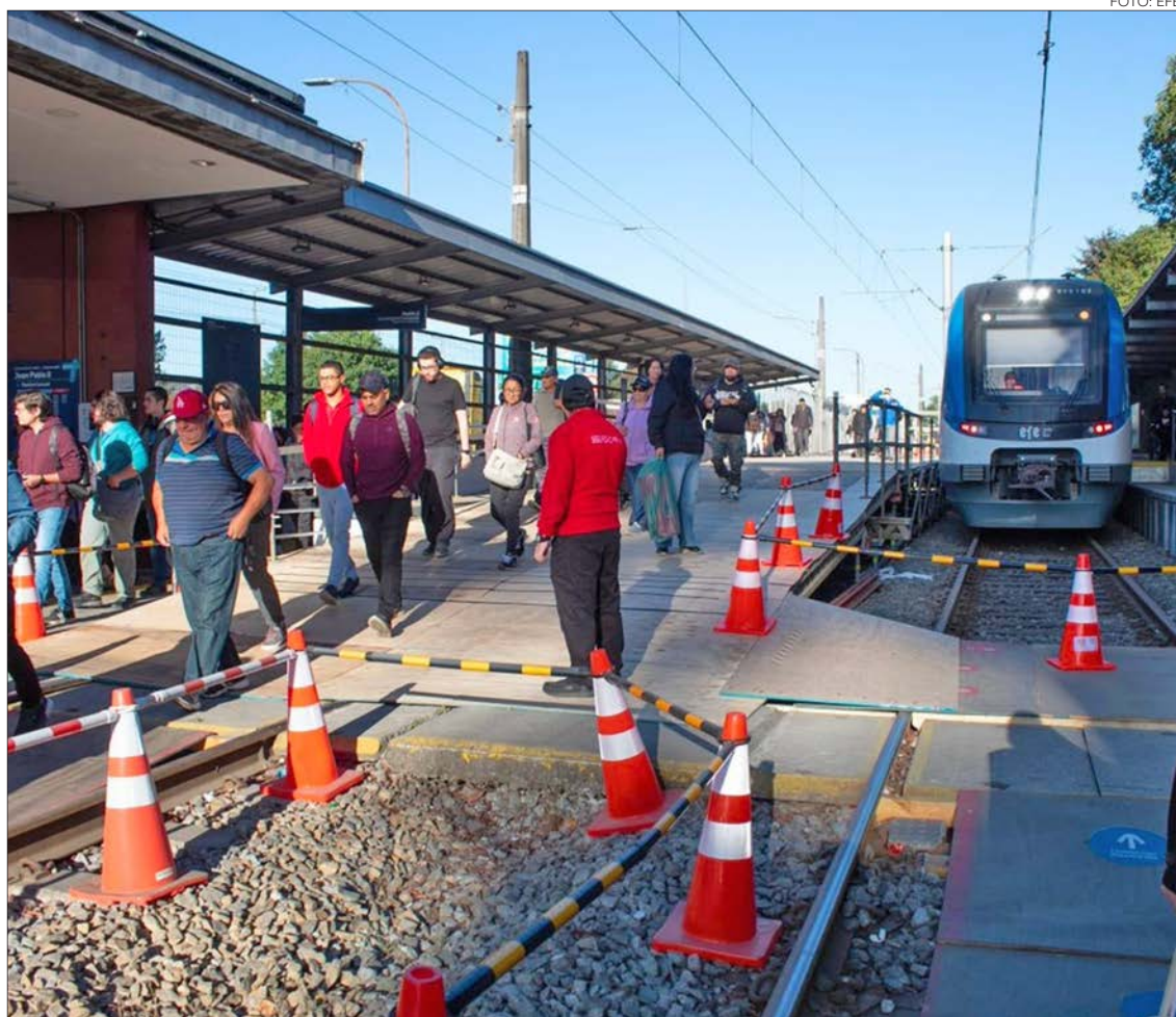
TRABAJOS EN ESTACIONES Juan Pablo II y Concepción están próximos a finalizar para mejorar transbordos.
