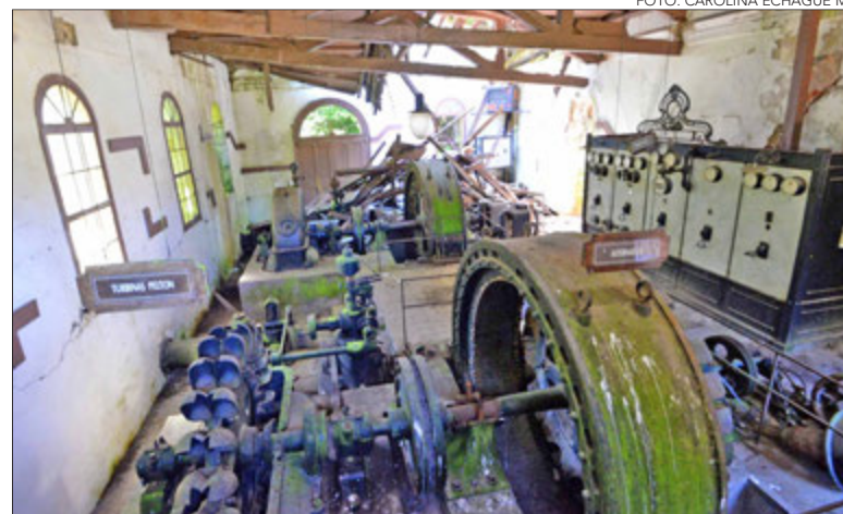
CENTRAL CHIVILINGO atraviesa por un litigio, el que una vez concluido se pretende incorporar a un recorrido turístico.
