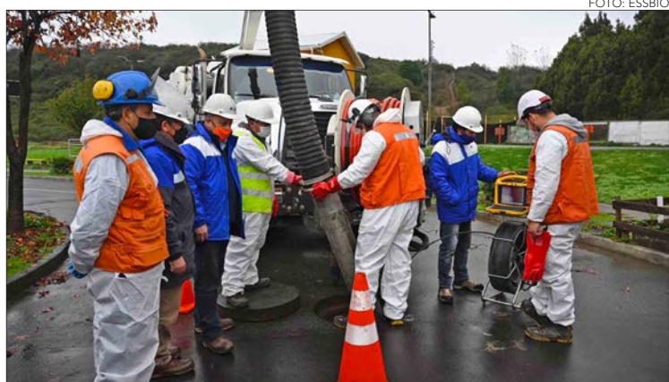
LA SANITARIA invertirá más de $800 millones en la limpieza de ductos.
