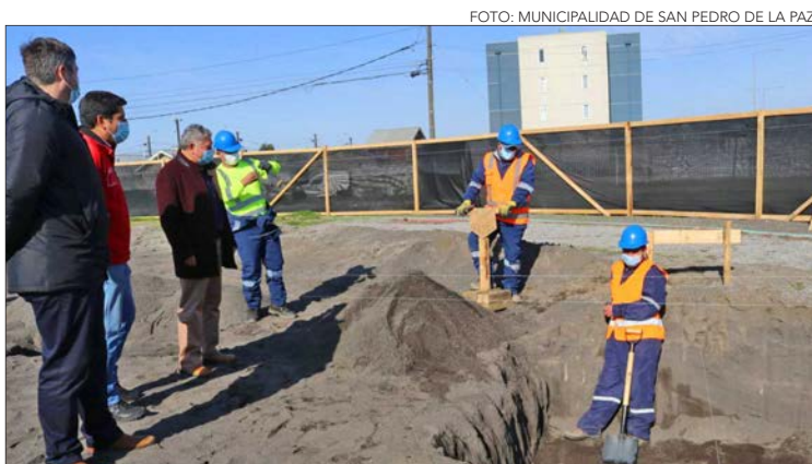
AUTORIDADES COMUNALES y regionales recorrieron las obras.
