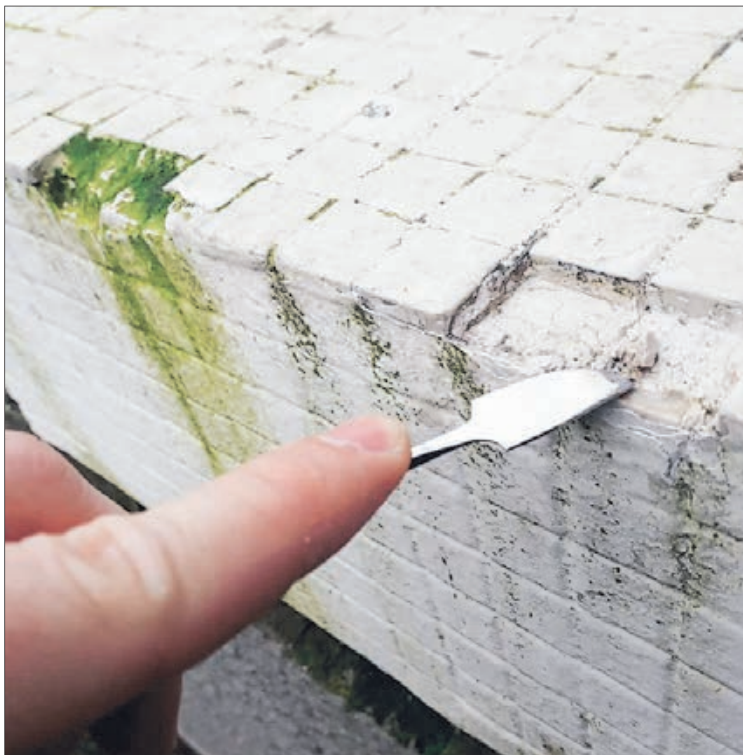
DETALLE de los mosaicos blancos que requieren restauración.
