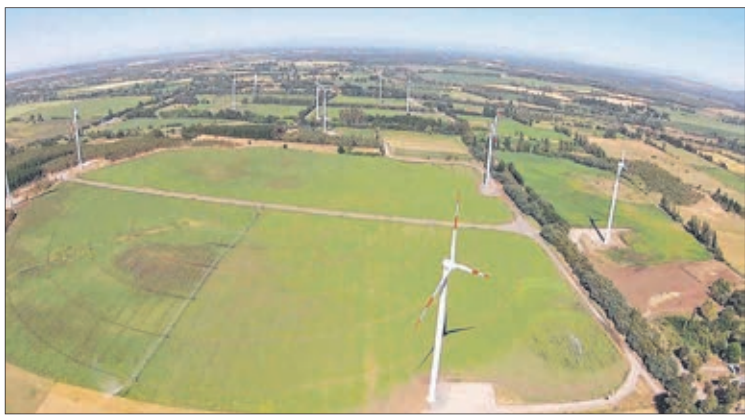
UNAS 15 hectáreas serán utilizadas por las obras del parque.
