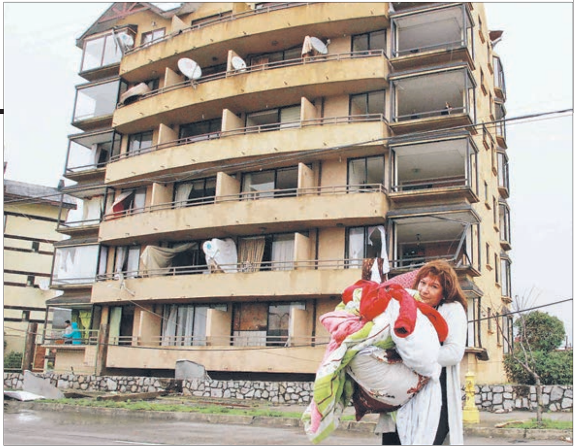
BRISAS DEL SOL fue uno de los lugares más afectados de la zona. Vecinos escaparon con lo puesto de las viviendas que resultaron con voladura de techos y ventanales rotos.
