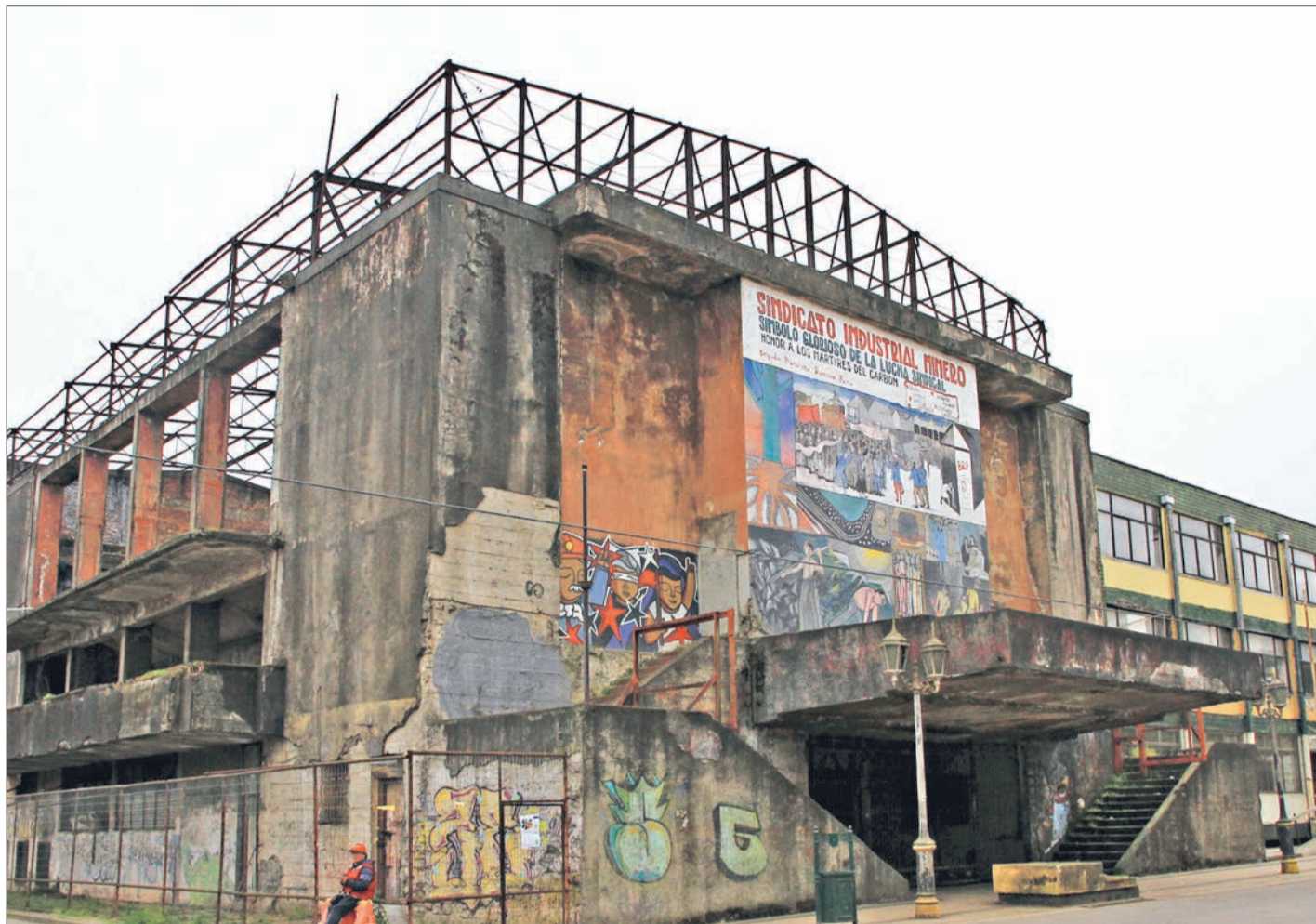
TEATRO DE LOTA, SINDICATO 6 Y EDIFICIOS CORVI
