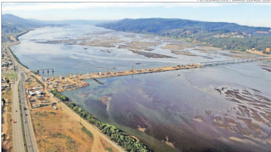
ASÍ LUCÍA EL PUENTE Chacabuco el 23 de febrero 2011 cuando se construían los pilotes.
