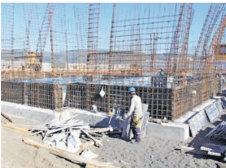
AUTORIDADES INSPECCIONARON OBRAS que tienen 21% de avance.
