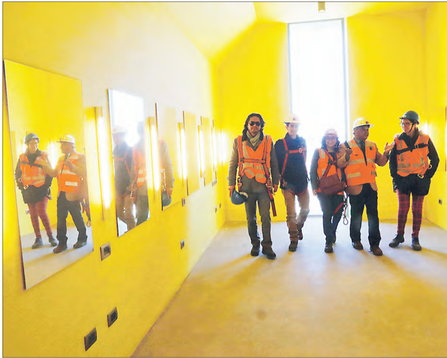
AL SECTOR DE LOS CAMARINES sólo les falta el acabado del piso y los detalles menores de limpieza.
