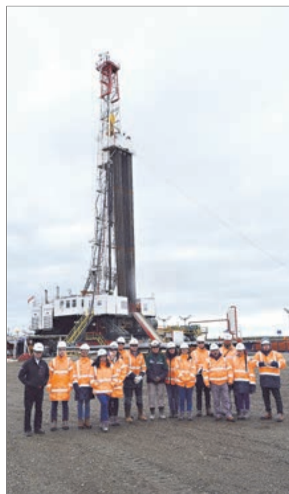
En sector arenal equipo de perforación N°6
