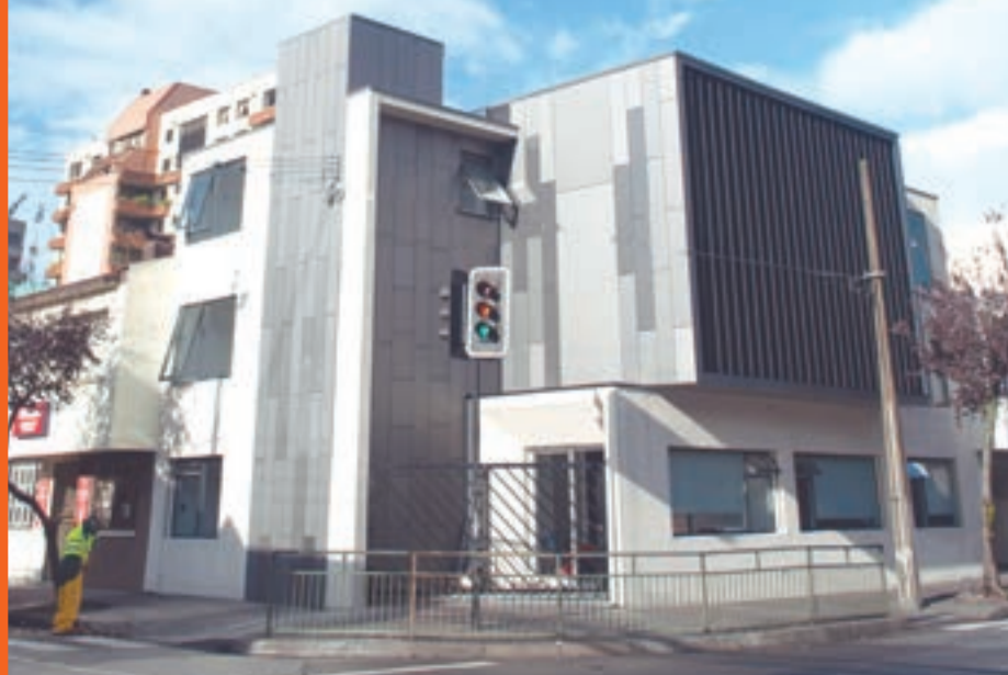
Salas 199, esquina Cochrane
